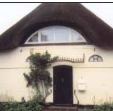
Eingangsbereich und grosszügige Gaube unter dem Reetdach
